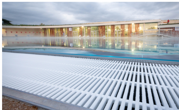
Ces grilles de débordement garantissent la stabilité, l'hygiène aux abords des bassins, et diminuent le risque de chutes.
