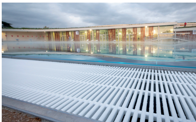
Ces grilles de débordement garantissent la stabilité, l'hygiène aux abords des bassins, et diminuent le risque de chutes.
